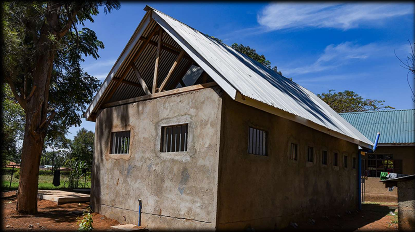
Die Toiletten- und Duschanlage im Vocational Training Centre wurde renoviert. Der Außenanstrich fehlt noch.
