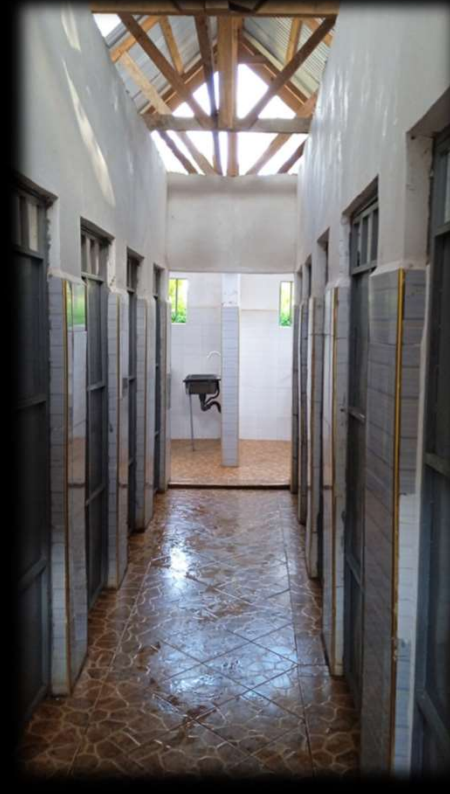
Ansicht nach der Renovierung
