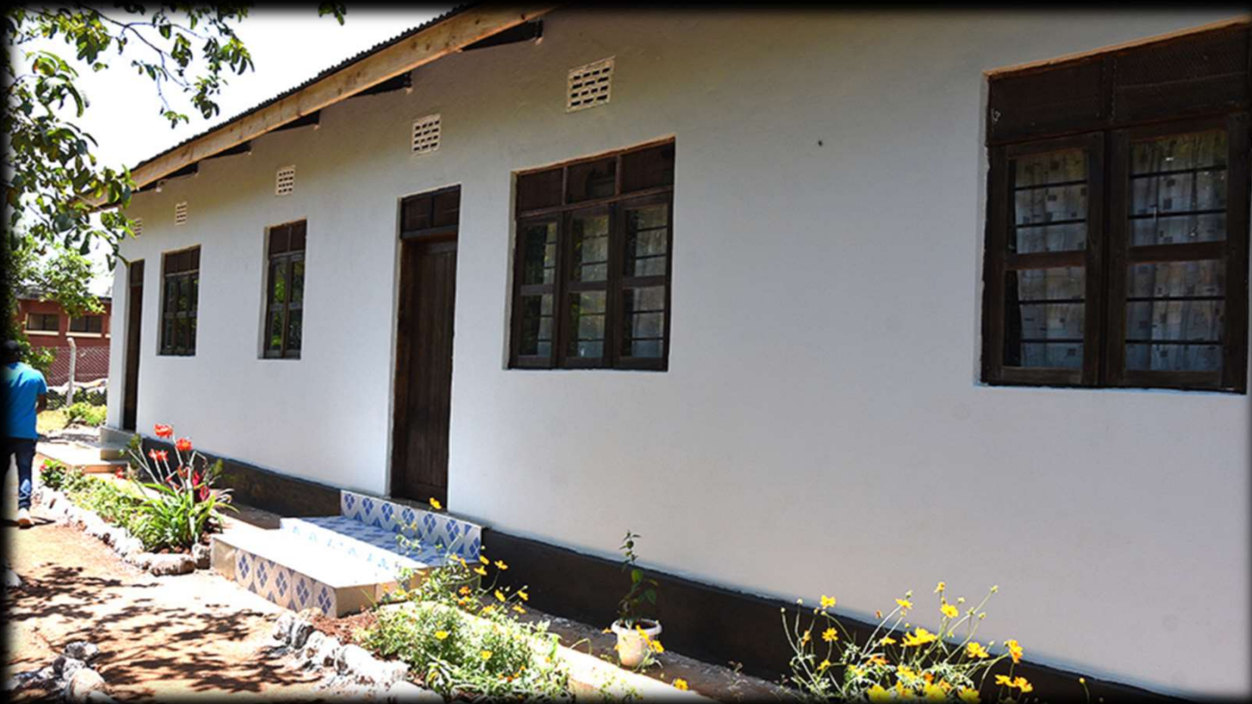
Das Volunteers House hat einen neuen Anstrich erhalten.
