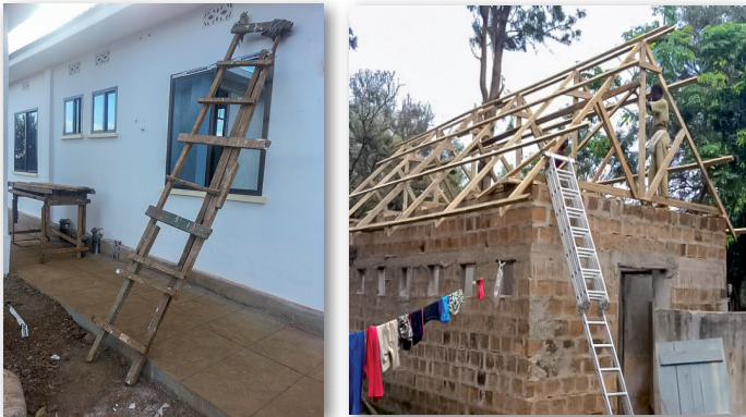
Links die alte Holzleiter, rechts die neue dreißigige Aluminiumleiter
